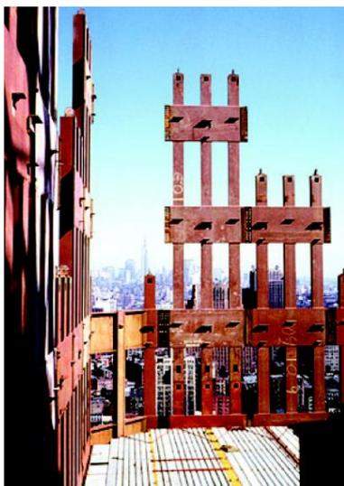
Рис. 16. Сегменты опор периметра    Рис. 17. Так это выглядело в реальности
