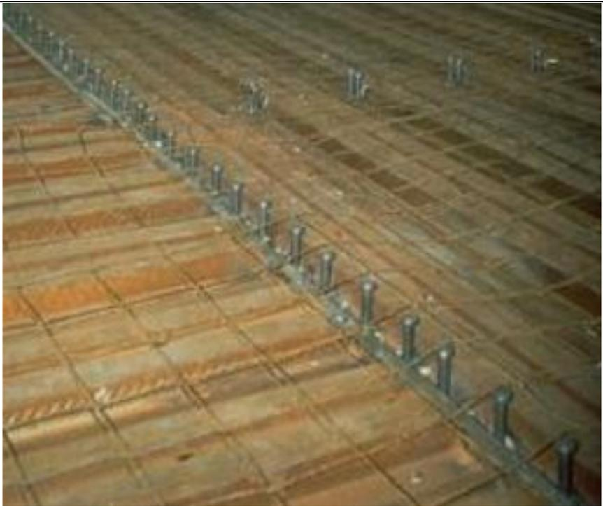
**Рис. 18. Рифленые платформы готовы к заливке бетона**
