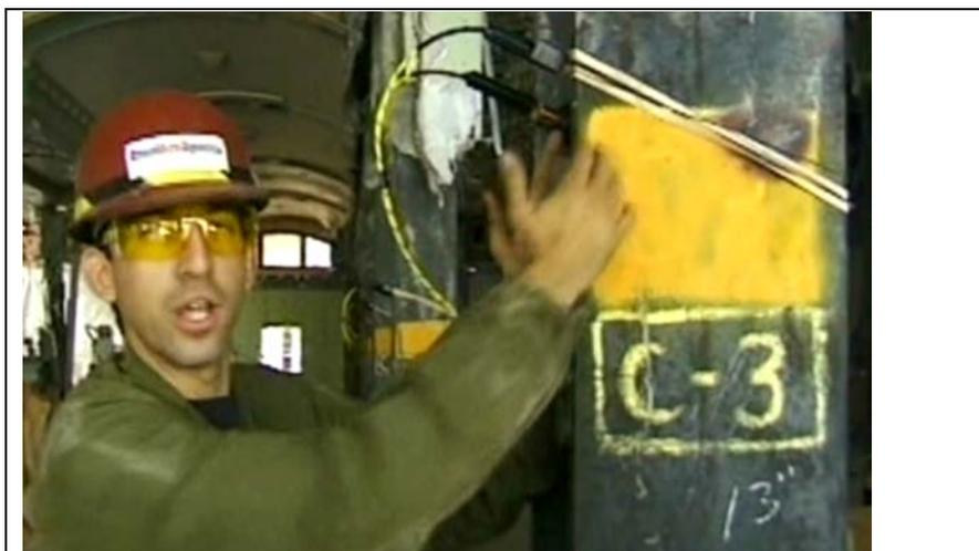
**Рис. 26.** Взрывник демонстрирует крепление линейных зарядов на несущих опорах
