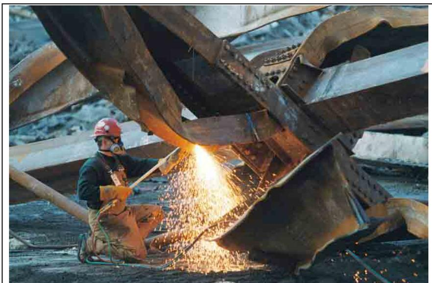
Рис. 24. Разбор стальных конструкций
