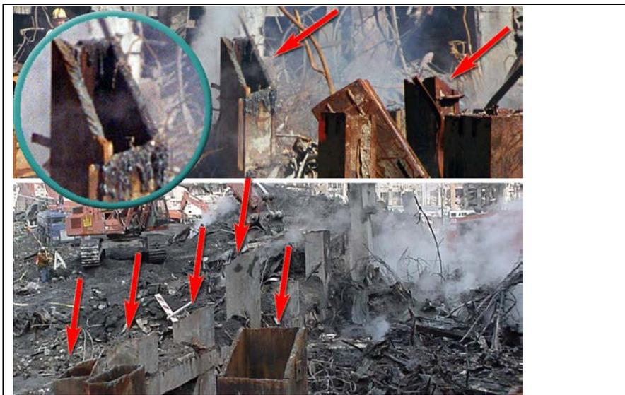
Рис. 29. Останки несущих опор центрального каркаса
