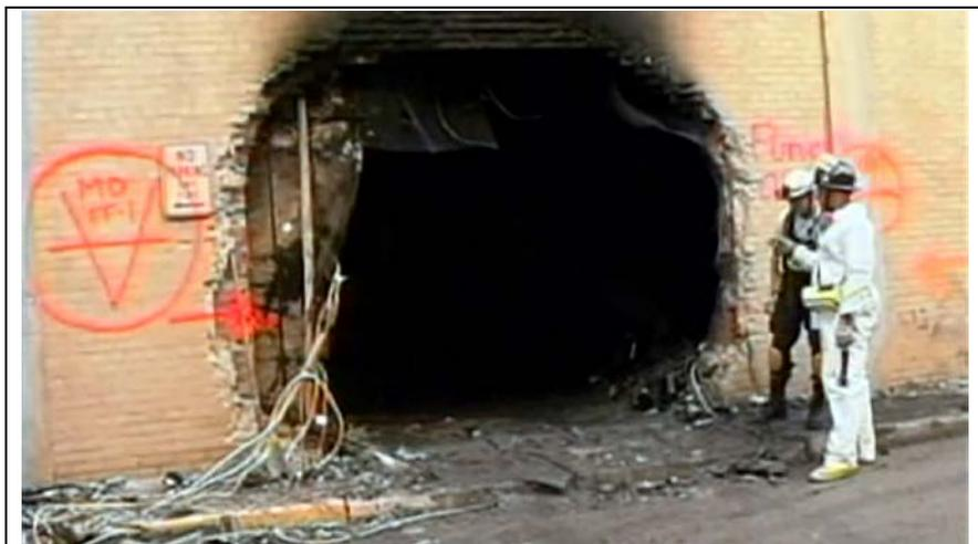
Рис. 51. Отверстие во внутренней стене кольца *C*
